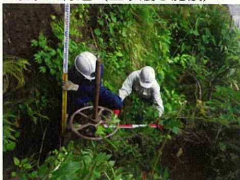
老朽化する水門施設（操作不能）
