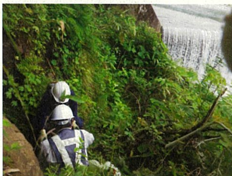
取水口付近（土砂履き施設）
