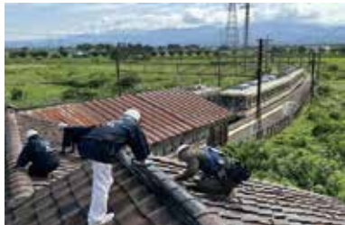
▲屋根瓦の状態を確認する瓦屋根診断技士
