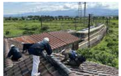
▲屋根瓦の状態を確認する瓦屋根診断技士
