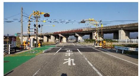
【改良後の日中田添線(踏切)】
