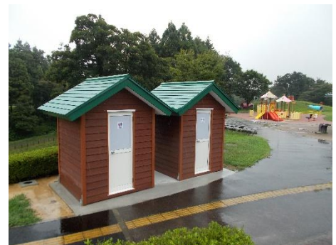
【総合公園に設置した簡易型トイレ】
