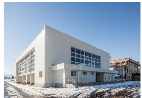
【改修後の高野小学校体育館】
