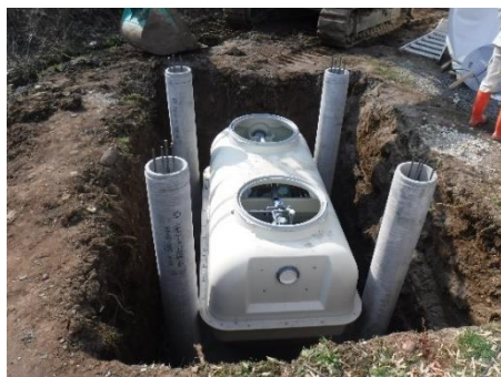
合併浄化槽設置状況
