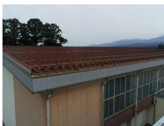
築 40 年以上経過した屋内運動場
