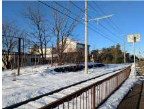
写真 18 上滝線上滝駅に現存している貨物ホーム（筆者所蔵）
