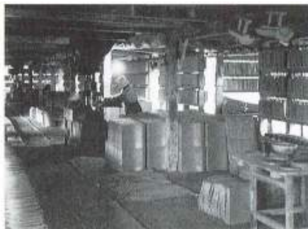
【写真8】昭和30年代頃の瓦工場内部（『新瀬戸地区のうつりかわり』より転載） 天井に吊り下げられている道具がキガタ。
