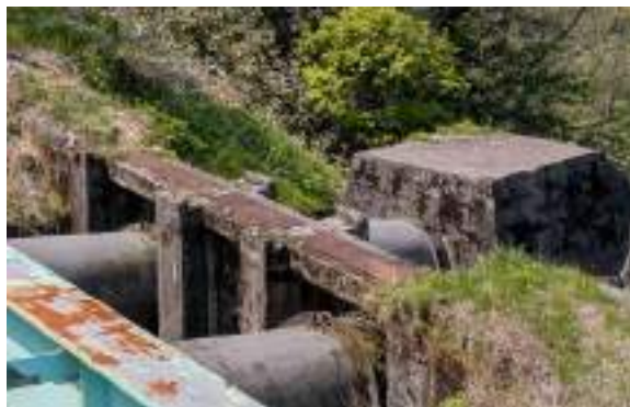
写真10 松ノ木発電所導水管上に現存する橋梁跡（筆者所蔵） 幅は狭いものの、コンクリート製のものが現存している。
