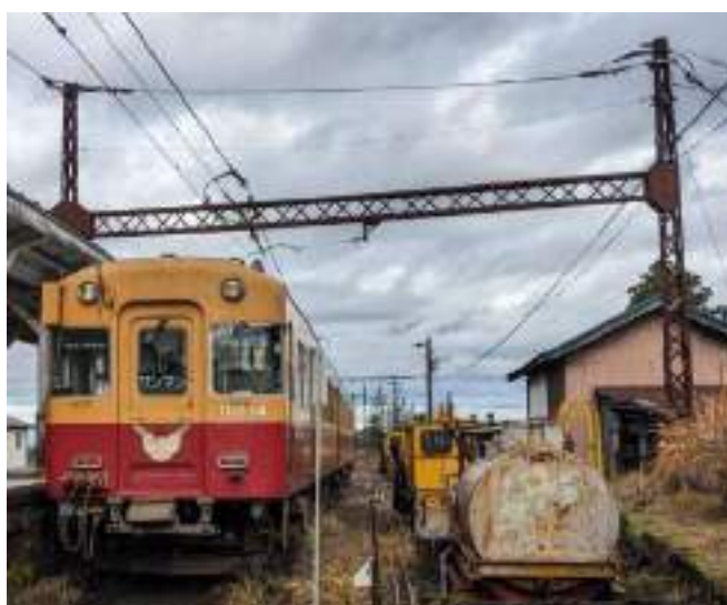
写真 3 芦峯寺駅に現存する原形の複線用の箆柱（筆者所蔵）
