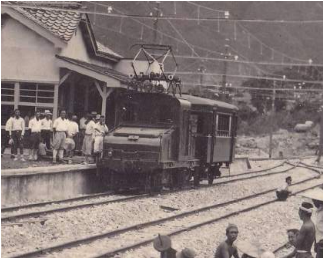
写真 7 粟巣野駅に停車するデキ 1 とハニフ 2 で組成された開業前の試運転列車（筆者所蔵）
