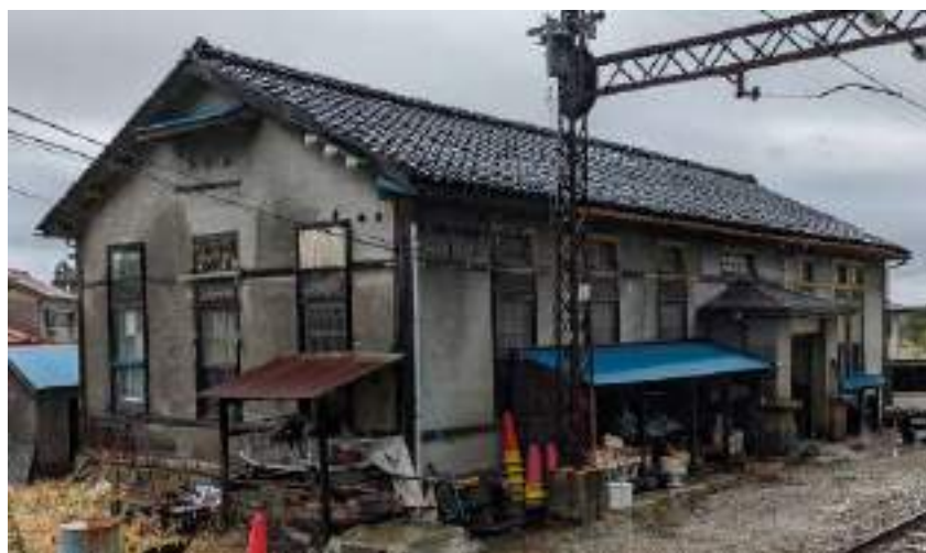
写真 1 芦峯寺駅に現存する変電所の建物（筆者所蔵）
