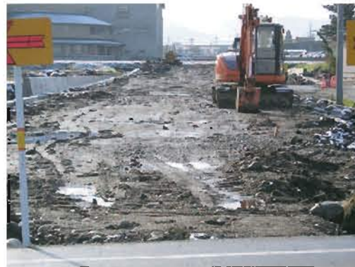
工事中の雄山中学校西側の新設道路
