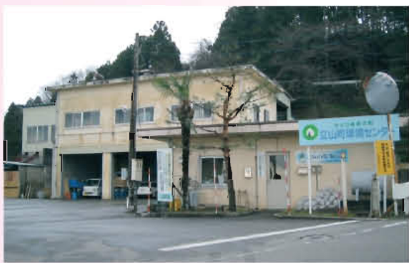
立山町環境センター
