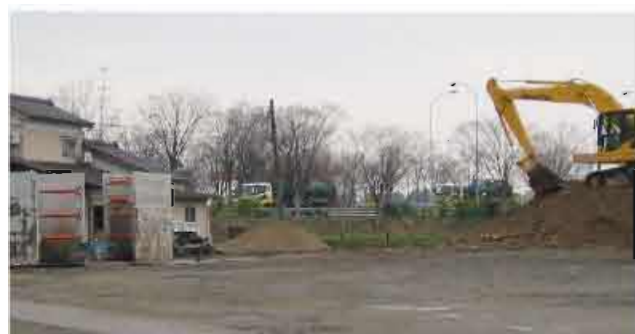
進む下水道整備(高原地区)
