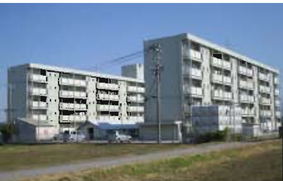
雇用促進住宅：前沢新町
