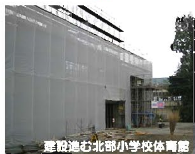
建設進む北部小学校体育館
