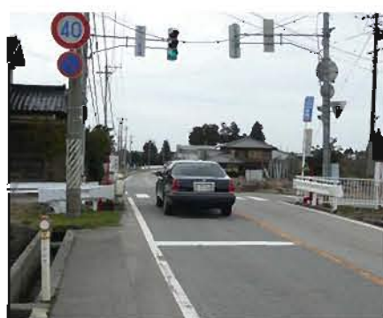
拡幅が望まれる橋(宮路)
