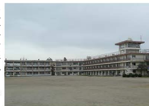
改築が見込まれる立山中央小学校
