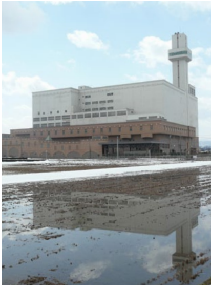
放射性廃棄物を焼却処理する ことが想定されていないクリー ンセンター
