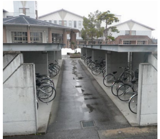
増設が望まれる雄山中学校駐輪場
