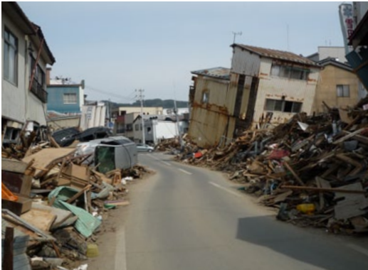
東日本大震災の被災状況
