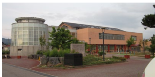
エアコン設置が望まれる小学校
