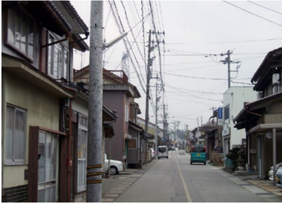
LED化する予定の防犯灯
