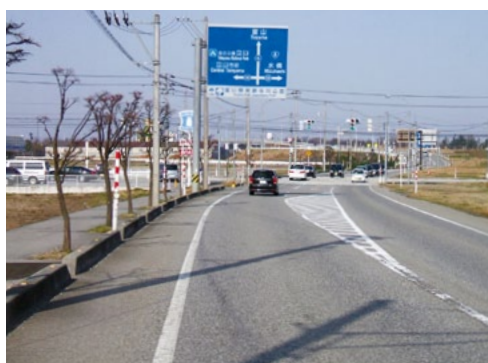
4車線化予定の県道(利田地内)
