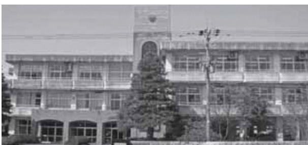
釜ヶ淵小学校
