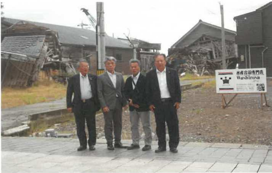
輪島被災朝市現場更地
