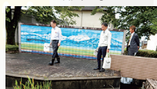
岩崎寺駅前公園トイレ等改修工事
