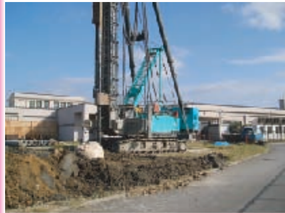
増築工事が始まったふなはし荘
