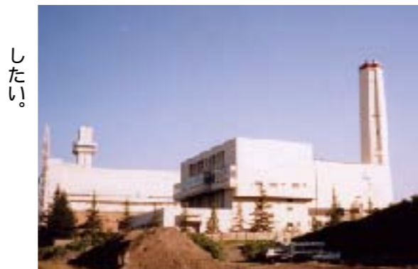
解体が待たれる旧クリーンセンター
