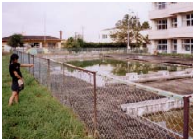
老朽化が不安な日中上野小プール
