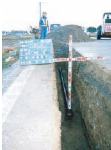
石綿セメント管取り替え工事
