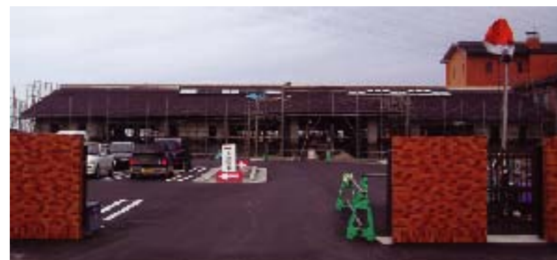
拡張工事が進む事務組合
