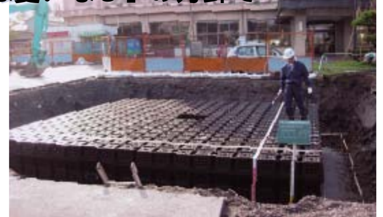
雨水貯留施設工事(役場)
