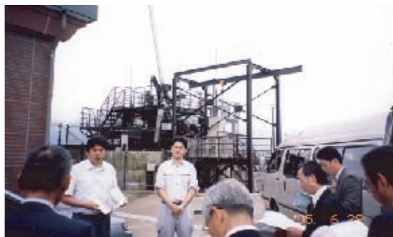
小水力発電所(白山市)
