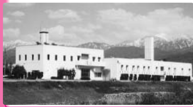
富山県中部衛生センター組合(上市町稗田)
