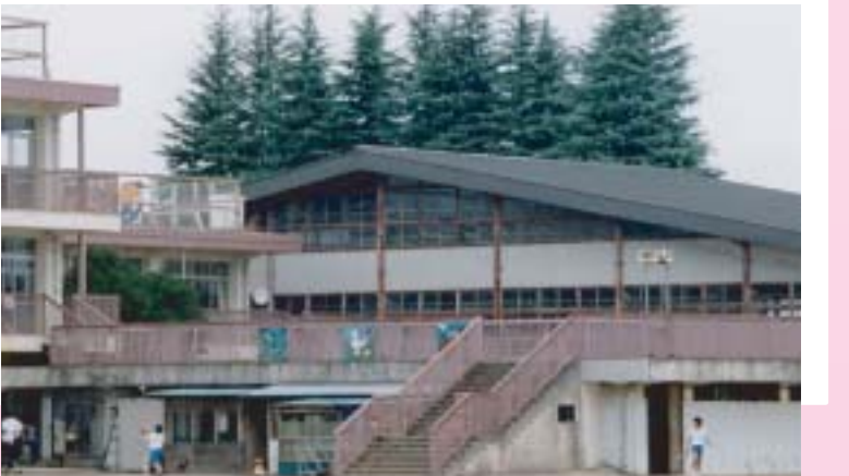
老朽化した体育館
