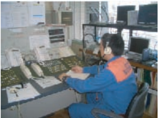
立山町消防署司令室
