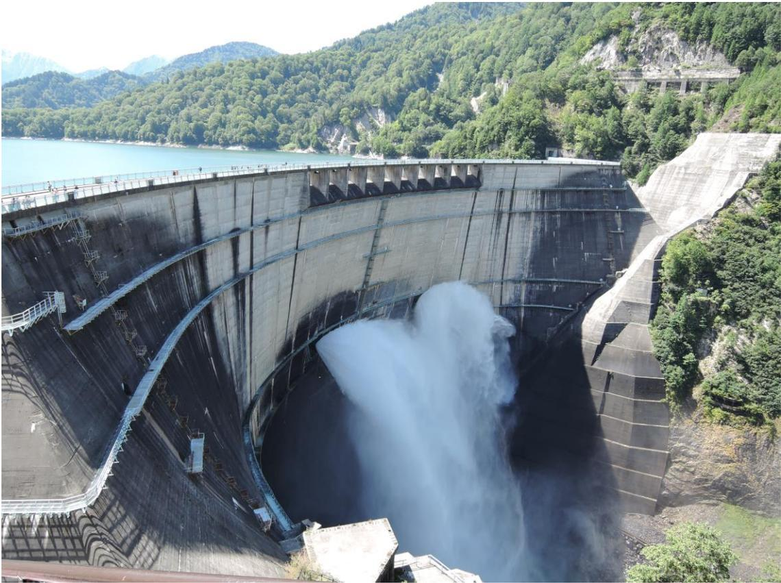
写真：黒部ダム(昭和38年竣工 アーチ式ドーム越流型ダム)
