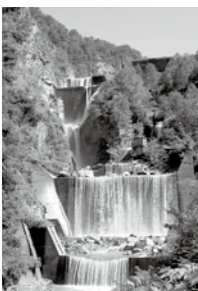
白岩砂防えん堤
