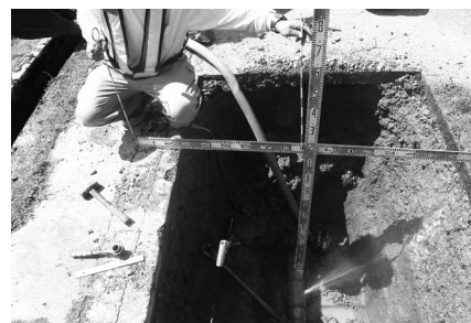
破裂した水道管
