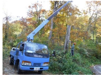
↑ 危険標柱の撤去作業
