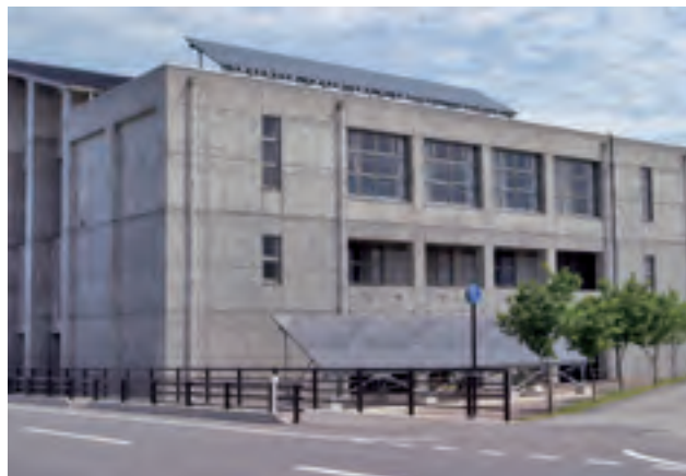
太陽光パネル（雄山中学校）
