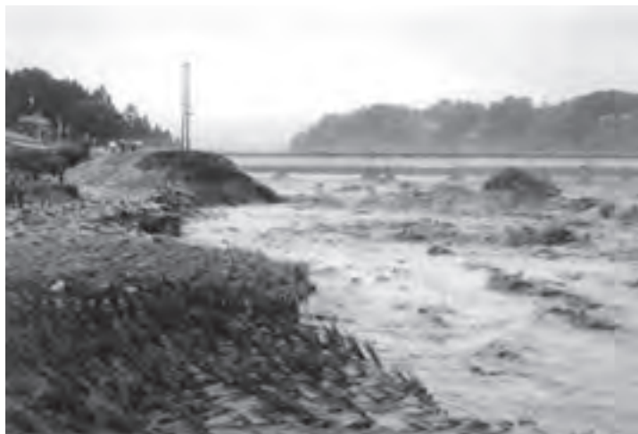
昭和 44 年 8 月洪水 常願寺川右岸岩峯野地先
