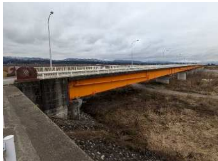
1. 町道泊新沢中山線 (雷鳥大橋) 平成13年架設 橋長278.6m、幅員10m
