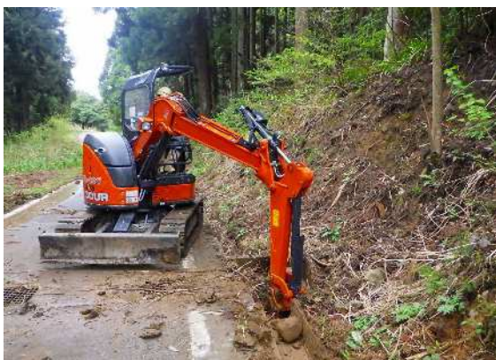
重機及び人力による側溝清掃作業
