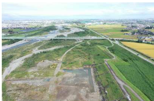
急流河川対策(着工前)
