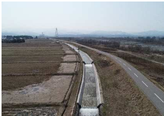
幹線水路の改修 (常東合口幹線地区)
