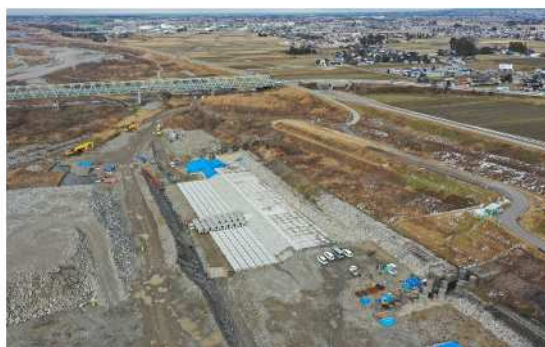
急流河川対策(着工後)
