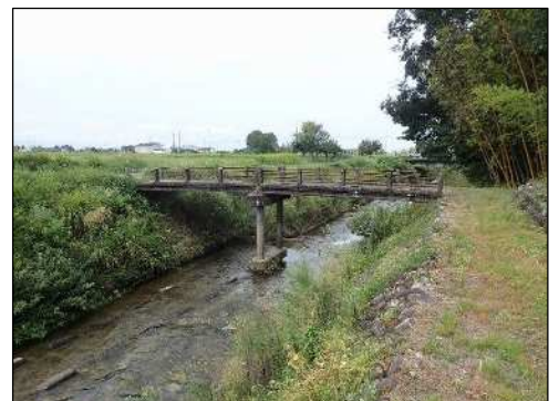
2. 管理者不明橋 (栃津川) 立山町 金剛寺地内 橋長 14.1m、幅員 2.6m
