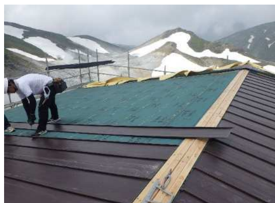
屋根の仕上げ工程（R7 雷鳥荘）
