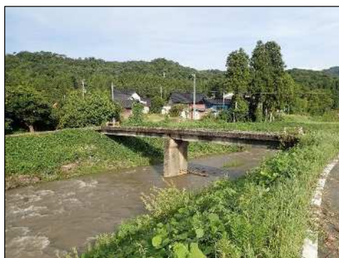
1. 管理者不明橋 (白岩川) 立山町 白岩地内 橋長 25.0m、幅員 2.6m
