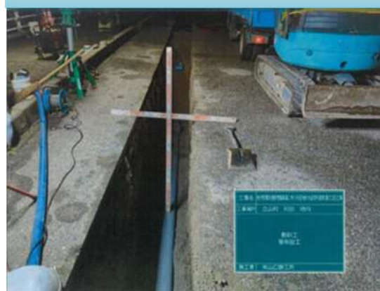
老朽管布設替工事の施工状況
