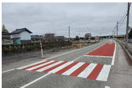
横断歩道のカラー舗装による対策例 （町道日中田添線）
