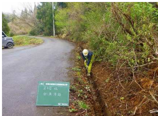
重機及び人力による側溝清掃作業
