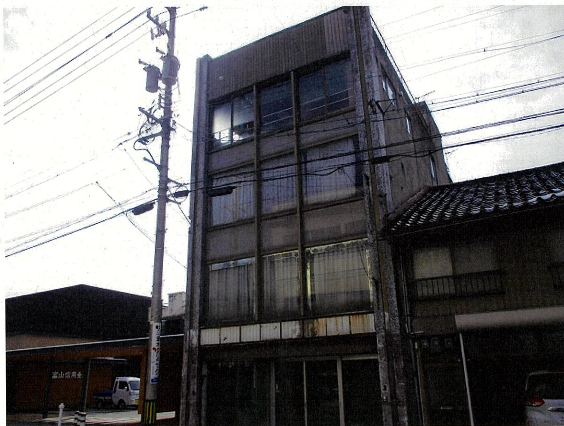
旧えんじ屋事務所ビル
