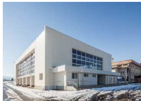
【改修後の高野小学校体育館】
