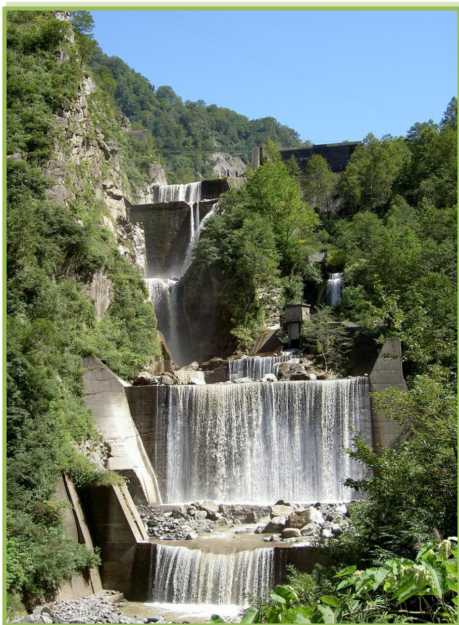
白岩砂防堰堤
