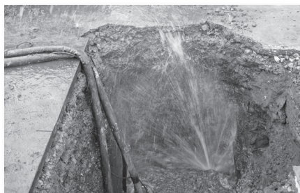
老朽管の破損による漏水
