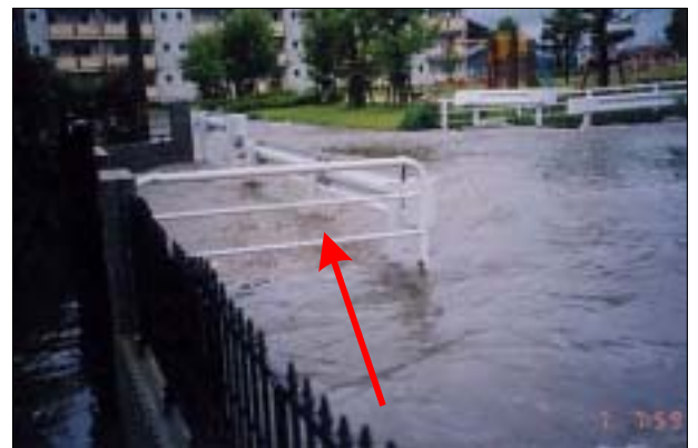
黒左エ門用水の被害状況 (前沢地区)
