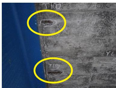
床版下面の鉄筋露出
