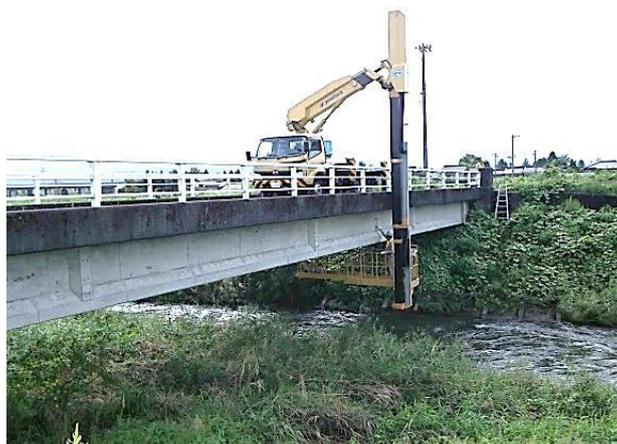
近接目視点検(橋梁点検車を使用)
