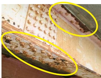
鋼桁の塗装はがれ・腐食
