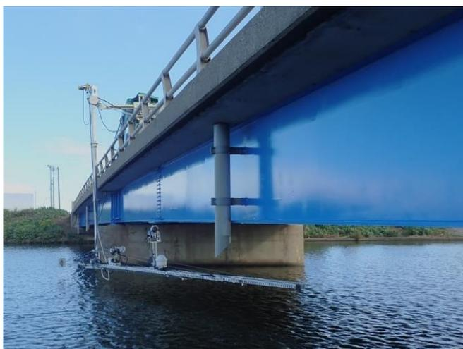
アーム形ロボットカメラによる点検
