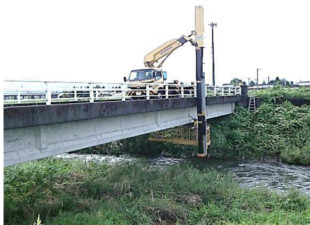
近接目視点検(橋梁点検車を使用)
