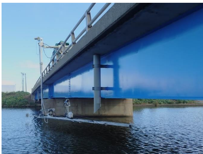
アーム形ロボットカメラによる点検
