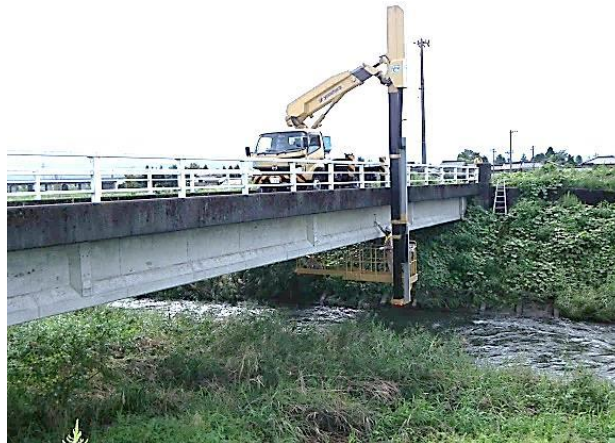
近接目視点検(橋梁点検車を使用)
