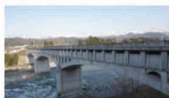
（左岸連絡水路橋）
